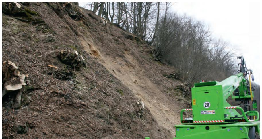
Pneumatisch betrieben und in jede Richtung schwenkbar ist die neue Bohrlafette. 60 Tonnen Gestein und Erde rutschten von diesem Hang auf einen Spazierweg entlang der Sieg. Daniel Kühr hat den Hang mit einem Stahlnetz gesichert.
